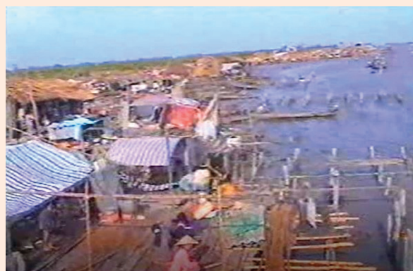
Nhà cửa bị tốc mái, đổ sập do bão.
