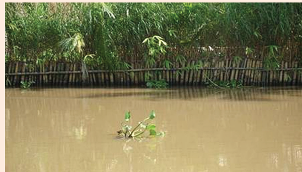
Giải pháp bảo vệ bờ bằng các cọc tràm, tấm phen liếp để chắn sóng ở tỉnh Cà mau.
