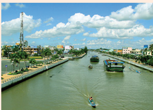
Kè đứng Kênh Xáng Xà No, tỉnh Hậu Giang (KC1)
