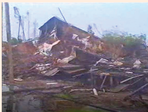
Nhà cửa bị tốc mái, đổ sập do bão.
