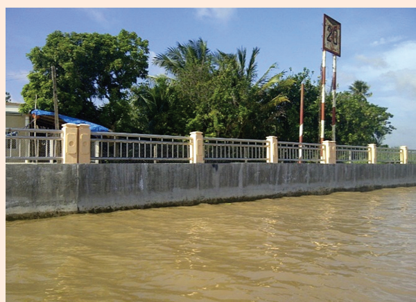
Kè tường đứng kết hợp mái nghiêng Tân Long - Tiền Giang (KC2)
