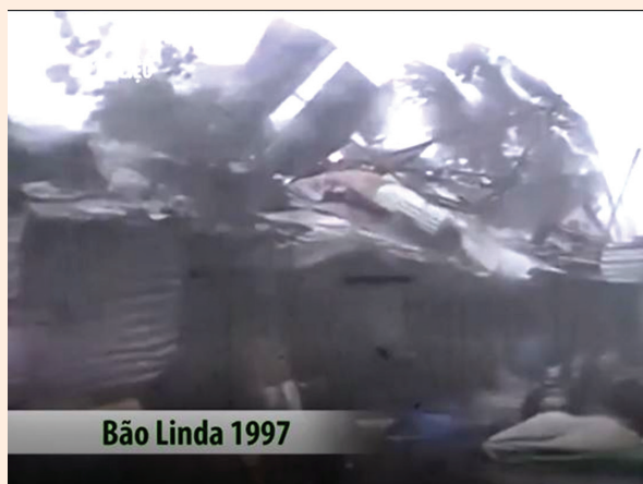
Nhà cửa bị tốc mái do bão.
