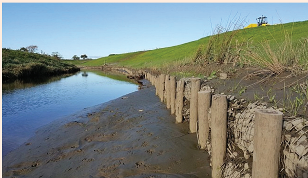
Giải pháp bảo vệ bờ bằng các cọc gỗ kết hợp rọ đá gia cố chân.
