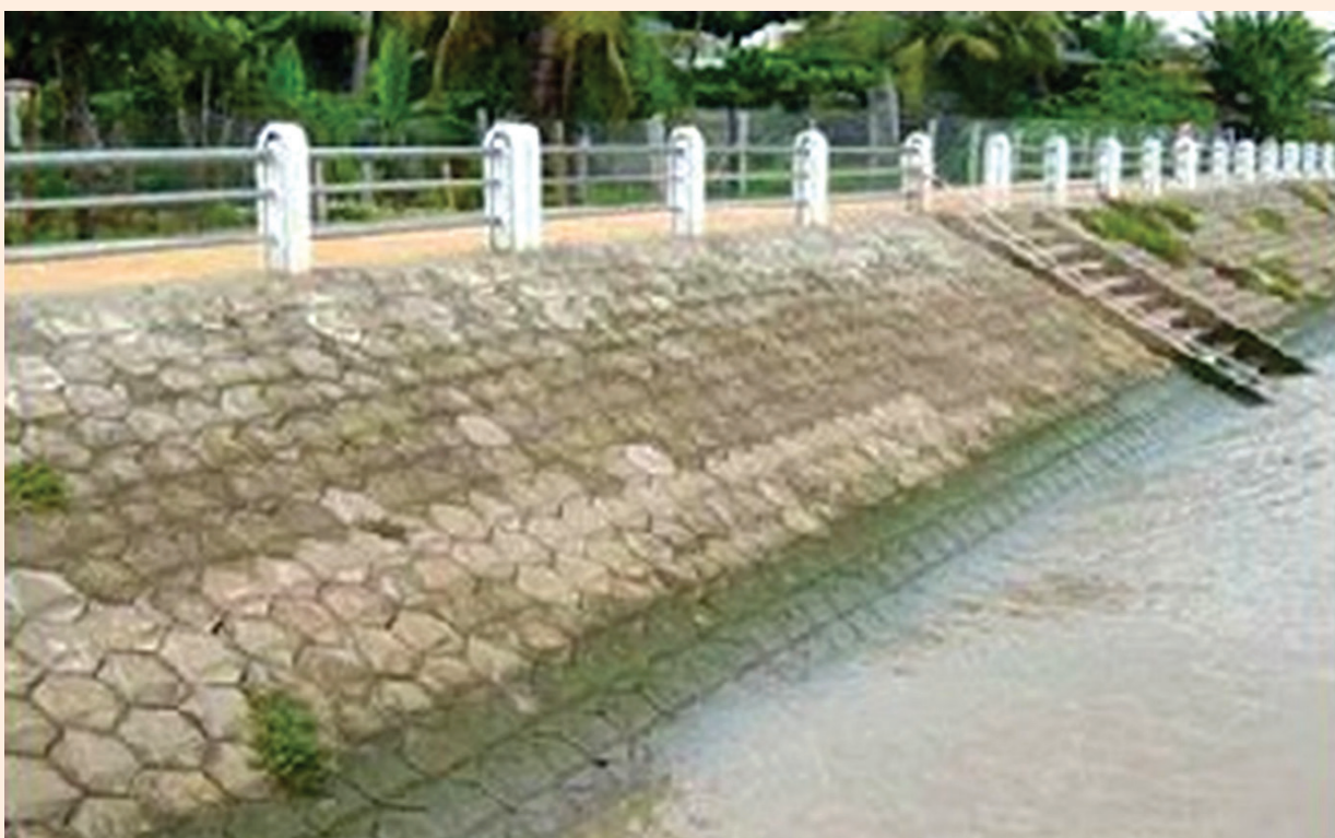
Kè bảo vệ bờ mái nghiêng bằng cấu kiện bê tông ở Sa Đéc (KC3)
