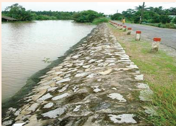
Kè mái nghiêng xây đá ở tỉnh Kiên Giang
