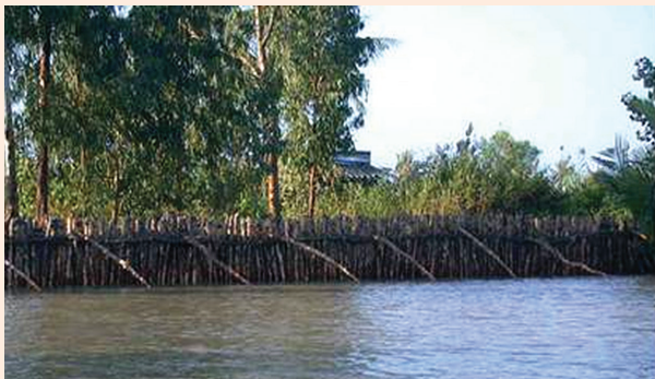
Giải pháp bảo vệ bờ bằng các cọc tràm, tấm phen liếp để chắn sóng ở tỉnh Cà mau.
