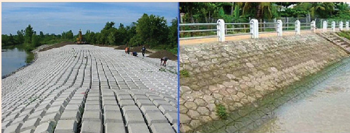
Hình - Kè lát mái bằng tấm bê tông.
