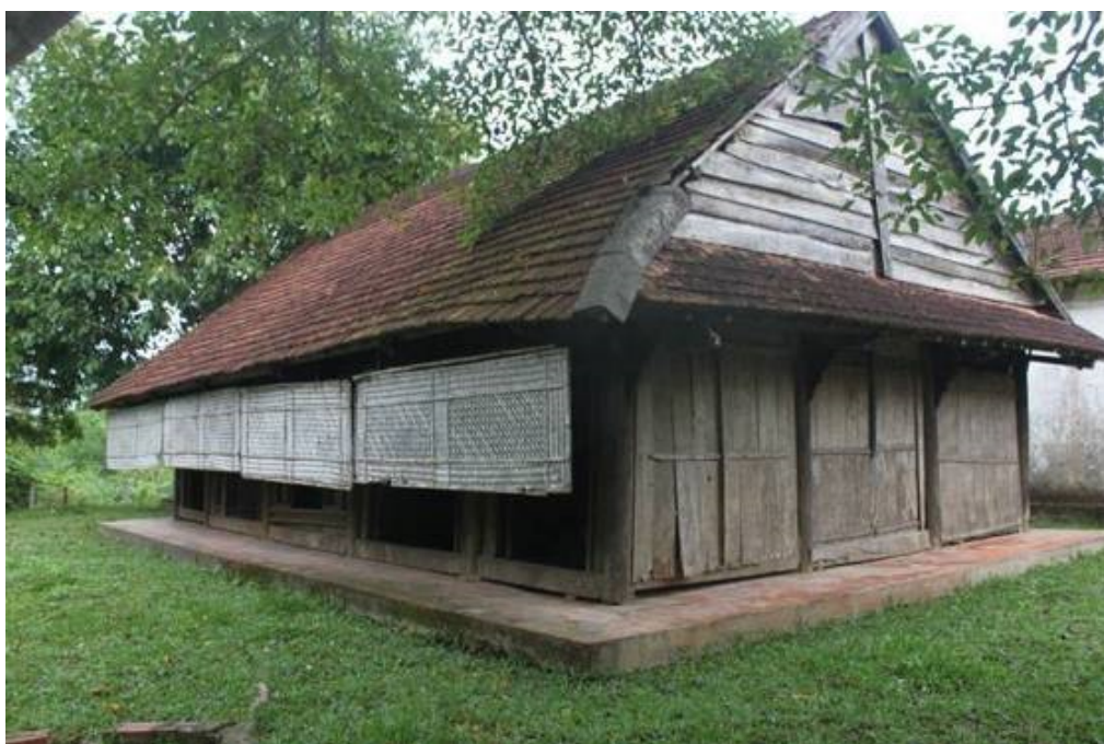
b) Nhà cổ chỉ có cột bằng gỗ bèn chắc
